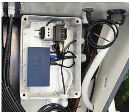
Dessin 16 : Module de connexion cascade avec câblage Ethernet
